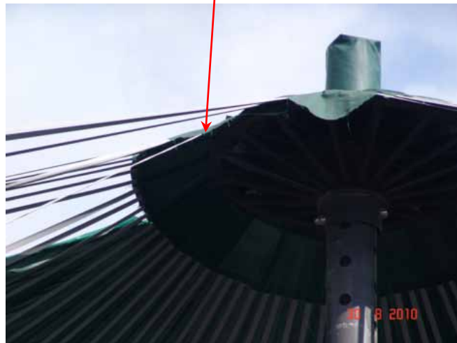
Initial-Riss unterhalb der Stützenhaube
