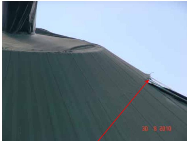
Initial-Riss unterhalb der Stützenhaube
