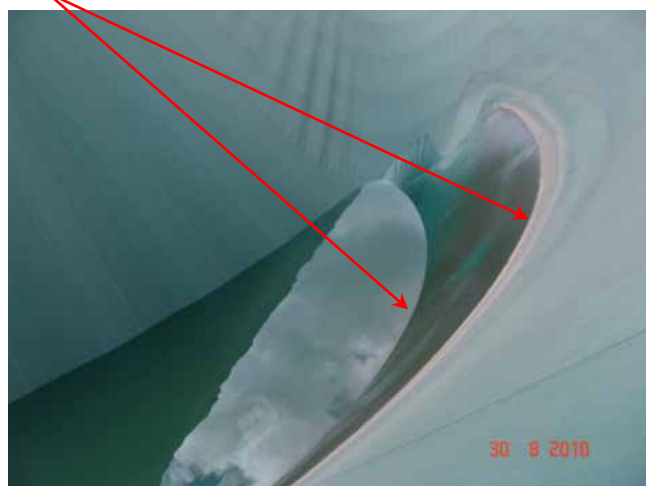
Im mittleren Silo verbliebener Wassersack auf der noch verbliebenen Dachhälfte. Die Ränder kennzeichnen die ursprüngliche Wasserstandshöhe.
