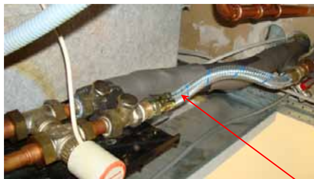
Einbausituation nach der erfolgten Sanierung durch Austausch gegen einen baugleichen Schlauch
