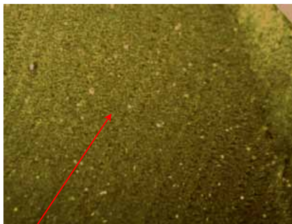
Homogener aber poröser Querschnitt des Schadensschlauches
